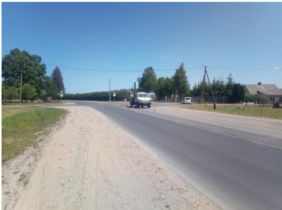
1 pav. Lauko darbai
